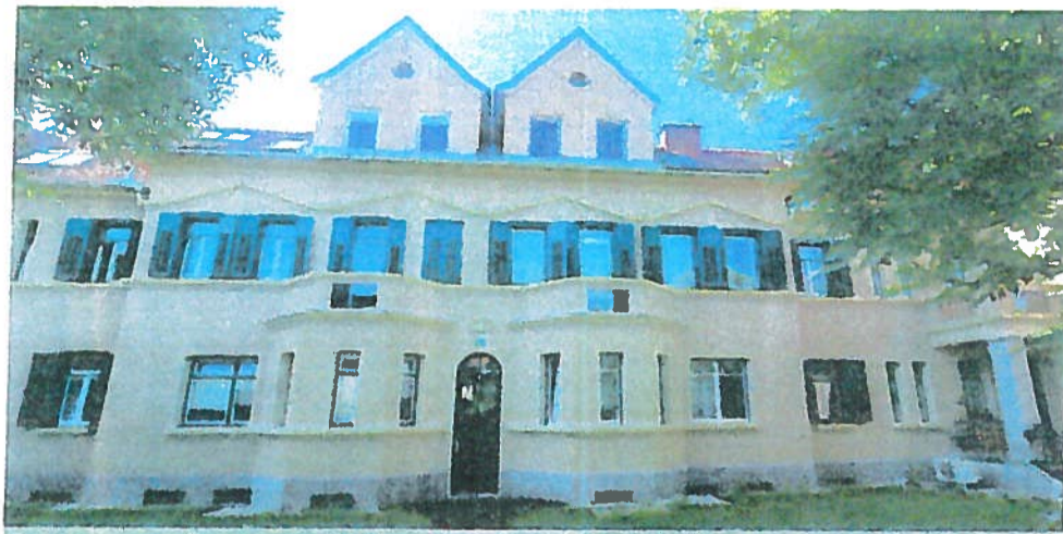
Prenova stavbe je poudarila njeno bogato arhitekturno vrednost.
