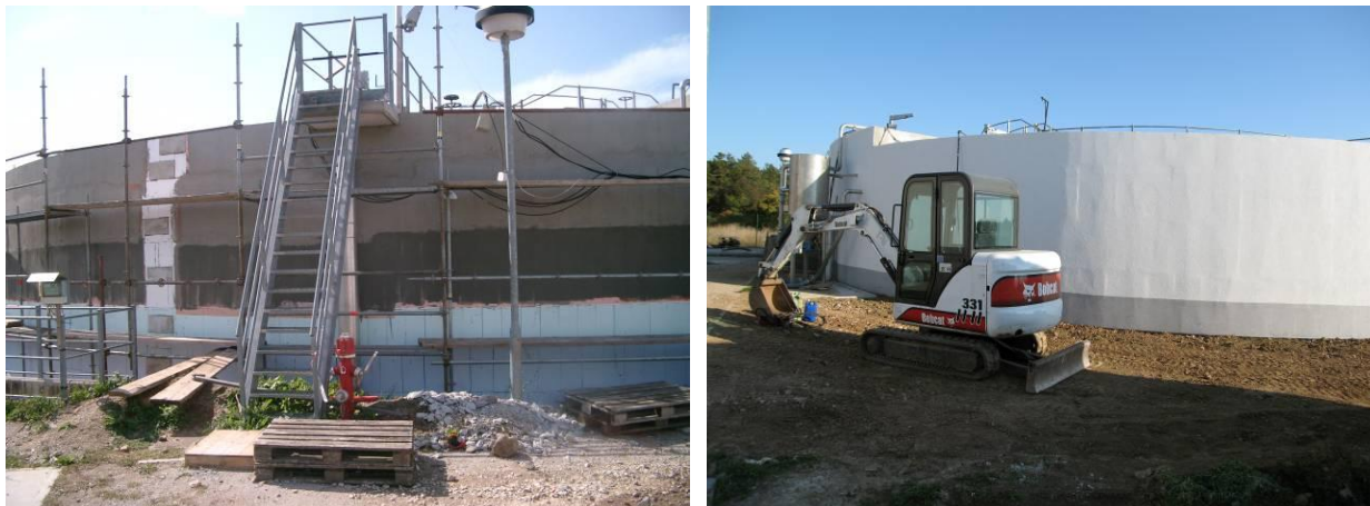
Slika 7: Nameščanje 8 cm sloja toplotne izolacije na zunanje površine obodne cilindrične stene čistilnega bazena odpadnih voda. Na desni sliki prikazujemo čistilni bazen po dokončanju sanacijsko - ojačitvenih del.
