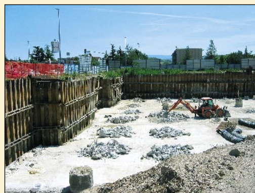
Dvokrat sidrane jeklene zagatnice
