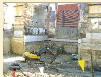
Opera - delni izkop diafragme
