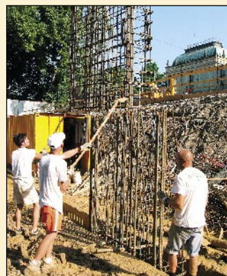
Opera - vstavljanje armature diafragme
