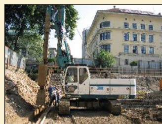
Opera - začetek izkopa diafragme
