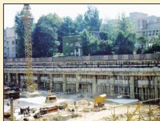
Sidrana pilotna stena za gradbeno jamo Cankarjevega doma v Ljubljani
