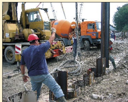
Vtiskanje jeklenih zagatnic
