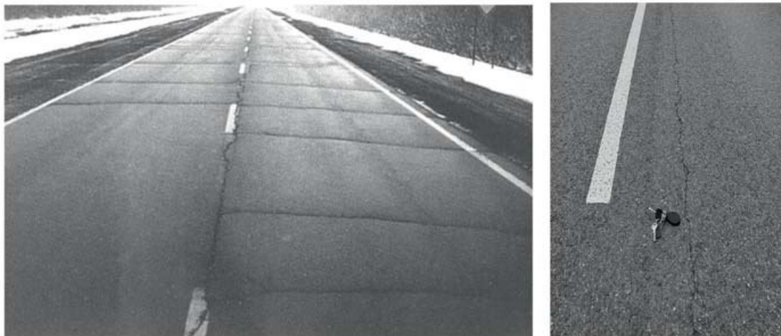
Slika 2.2: Poškodbe vozišča pri nizkih temperaturah [Spiegel, 2008]
